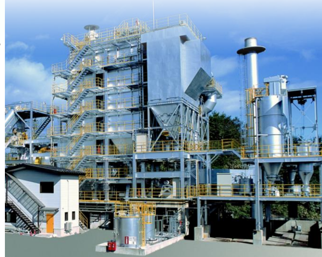
東北クリーン開発㈱ 焼却施設
