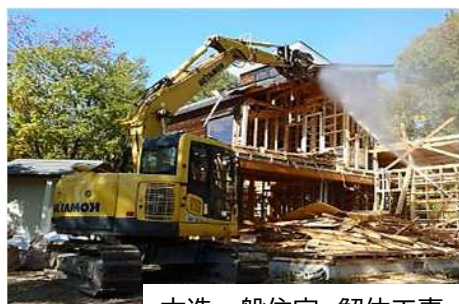
木造一般住宅 解体工事
