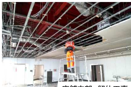
店舗内部 解体工事
