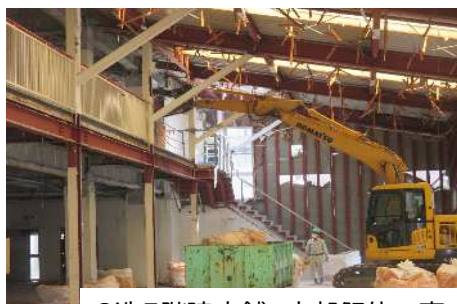
S造5階建店舗 内部解体工事
