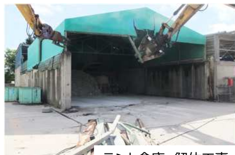
テント倉庫 解体工事
