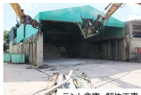
テント倉庫 解体工事
