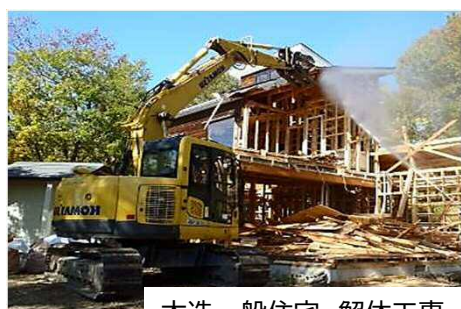
木造一般住宅 解体工事
