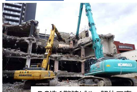
RC造6階建ビル 解体工事
