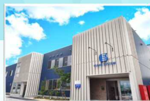
生産部管理棟
