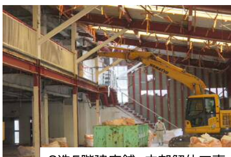
S造5階建店舗 内部解体工事
