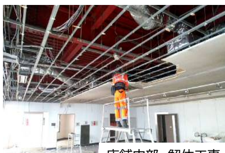
店舗内部 解体工事
